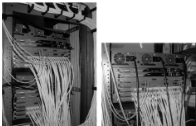
Fig.7 GIGAスイッチ(ルーセント・テクノロジー社製 P550)。
