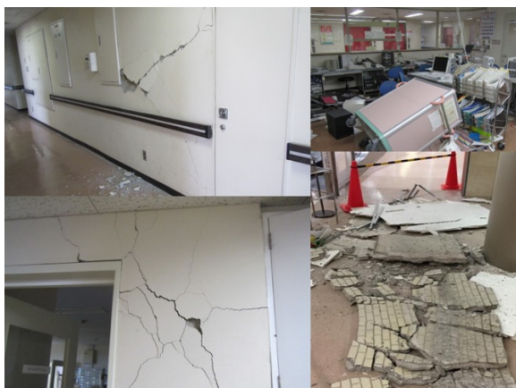
図-2 建物の損壊(壁面の亀裂、天井崩落など)
