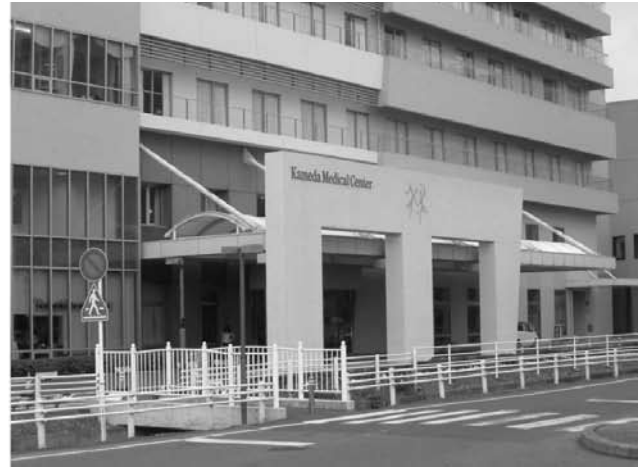
Photo 4 メディカルセンター玄関
