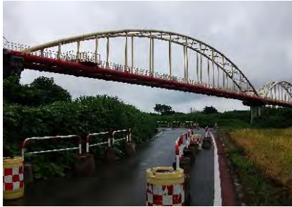
案内板から水管橋を望む
