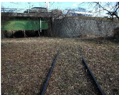
橋桁の手前で切断された線路
